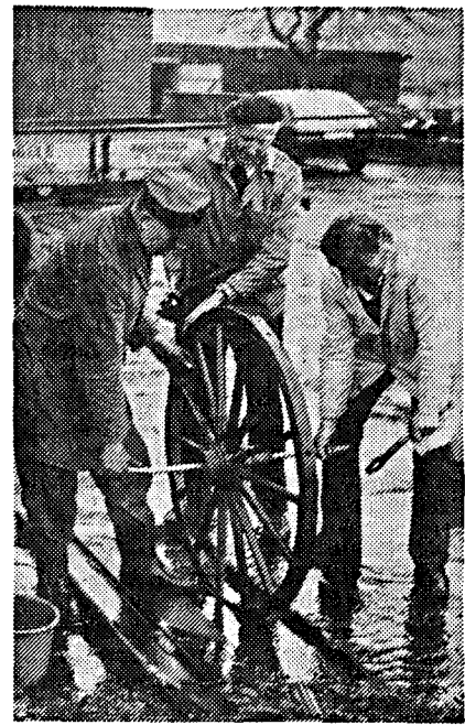
Der aufgezugene Reifen wird im Wassertrug abgekühlt und die Felge mit dem Hammer in das Eisenband eingerichtet. Aufn.. Foto-Seele, Todtenhausen
