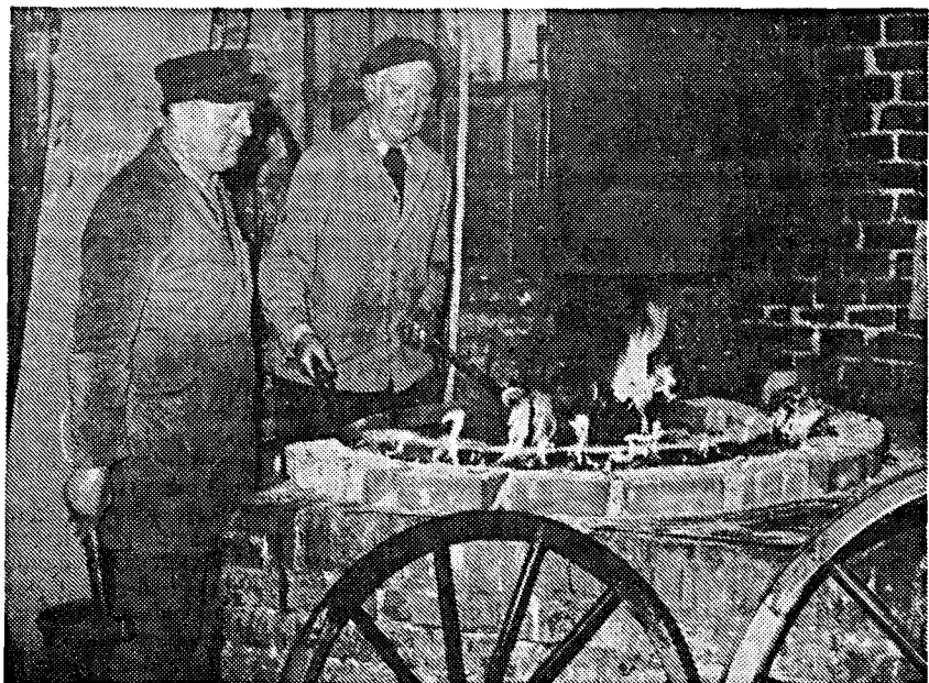
Der Eisenreifen wird im Schmiedefeuer erhitzt. Die beiden Schmiedemeister Heinrich Schwier (links) und Kurt Erdmann bei dieser Arbeit. Aufn.. Foto-Seele, Todtenhausen
