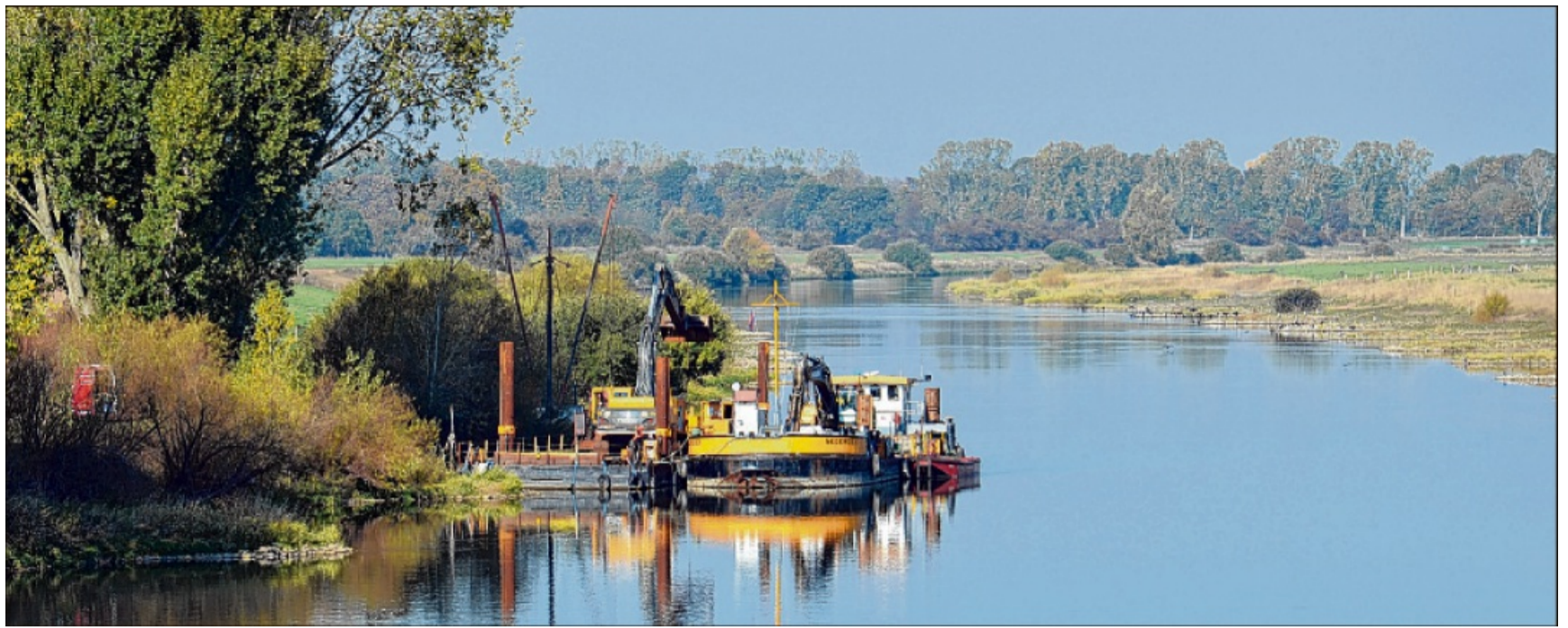
Das Arbeitsschiff Segerdiek ist bereits im Einsatz. Bis Mitte November sollen die Buhnen ökologisch aufgewertet sein. Die bestehenden Einbuchtungen sind auf der rechten Seite gut zu erkennen. MT-Foto: Oliver Plöger
